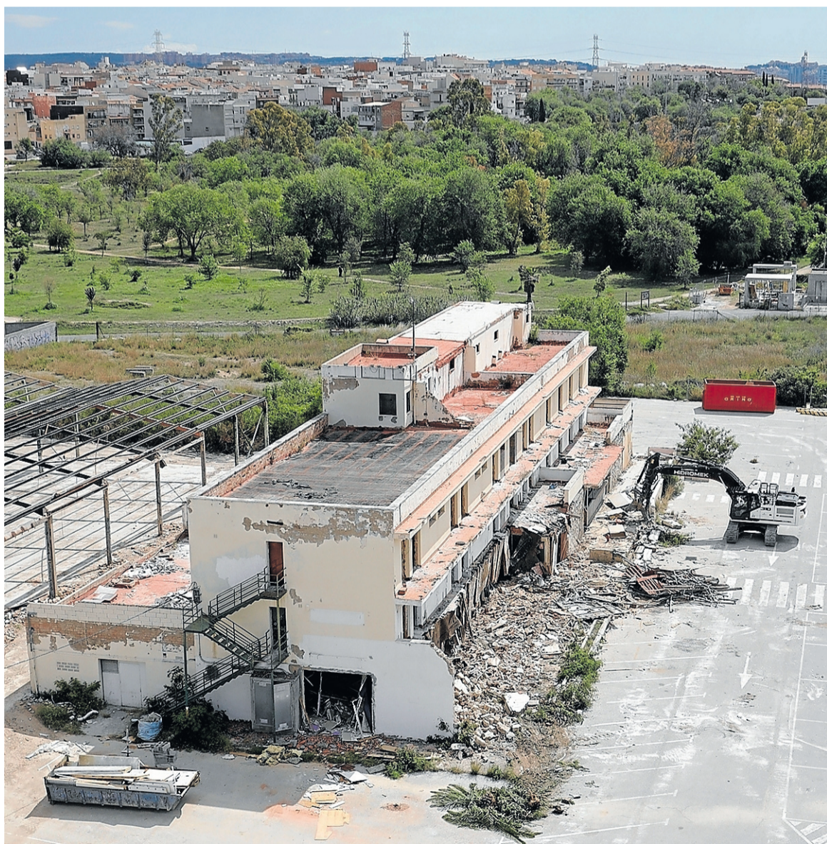
El derribo del icónico club nocturno situado en La Canonja comenzó ayer. FOTO:PERE FERRÉ
